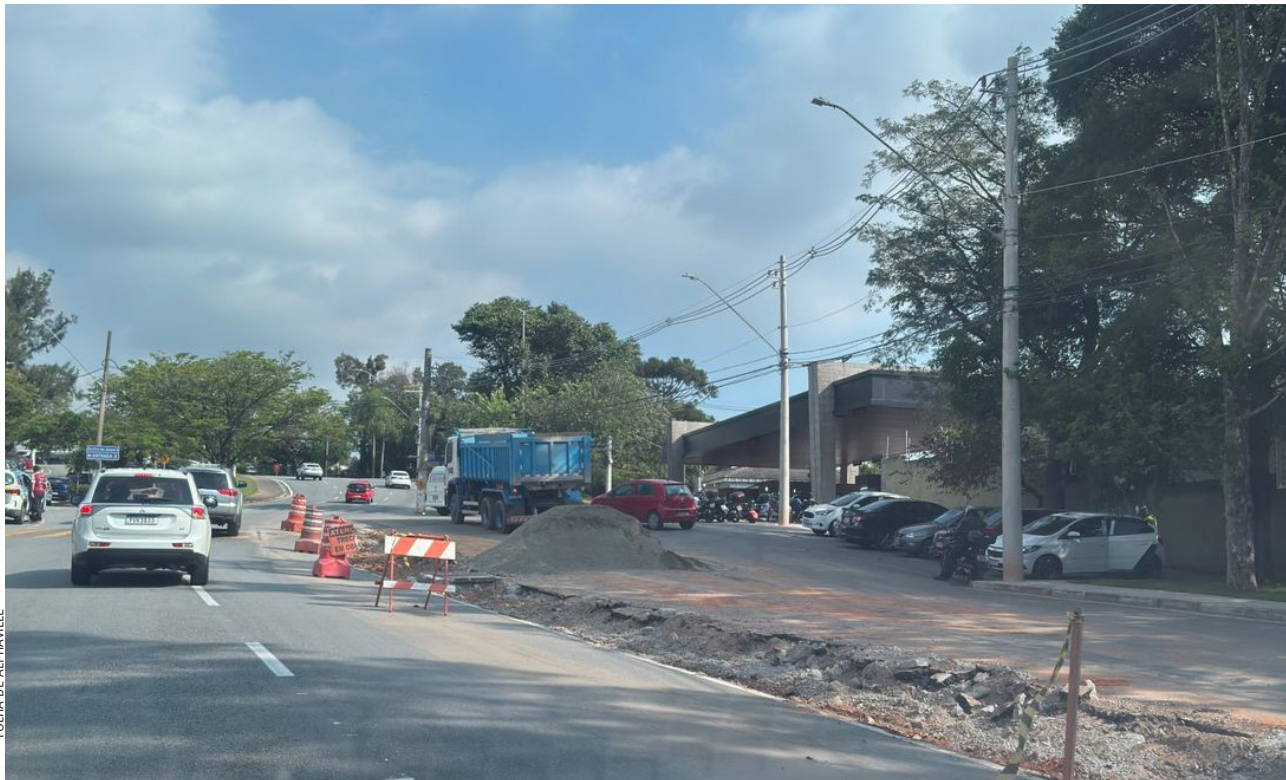
| AV. YOJIRO TAKAOKA. Além da ampliação de vias, será realizada a instalação de ciclovias e melhorias no sistema de drenagem, na iluminação e calçadas mais amplas
