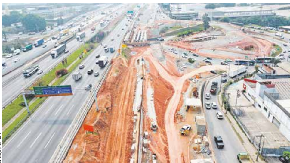
Trevo de Alphaville. Segundo a CCR, estão sendo construídos dois novos viadutos no lado leste do trevo, além do alargamento de um viaduto existente na pista expressa oeste
