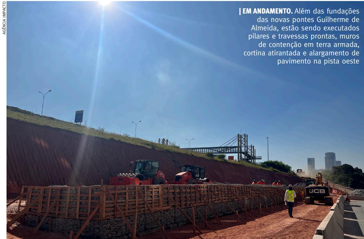
**| EM ANDAMENTO.** Além das fundações das novas pontes Guilherme de Almeida, estão sendo executados pilares e travessas prontas, muros de contenção em terra armada, cortina atirantada e alargamento de pavimento na pista oeste
