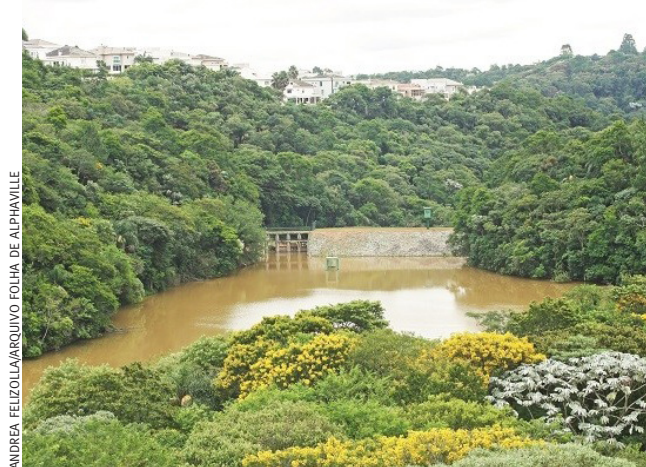
| AÇÃO. Sabesp é acusada de não ter tomado medidas para conter vazamento de esgoto na área
